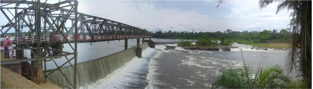
Situation en Mars 2008 à la fin d'une longue période d'inondation. L'ancien déversoir a été construit dans les années 50 et la sécurité n'est plus garantie. En conséquence, il existe un risque important de pertes énergétiques considérables au niveau de la centrale hydroélectrique EDEA ainsi que de l'usine Alucam de production d'aluminium et de la consommation énergétique domestique dans le sud du Cameroun. Le nouveau déversoir sera construit 6 m en aval de l'axe de l'ancien barrage.
